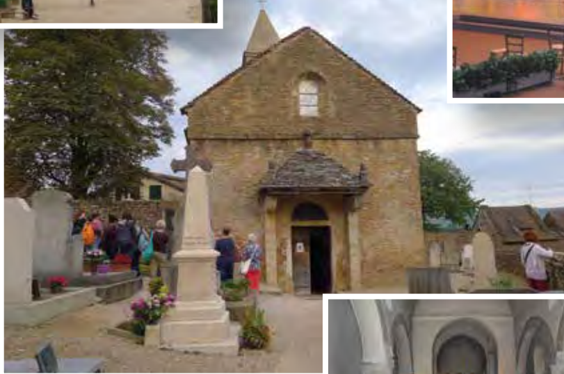
Exterieur van het oorspronkelijke kerkje met de begraafplaats
